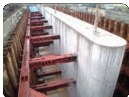
コンクリート打設
