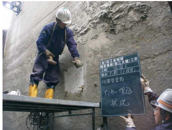
写真7 アンカーの埋め込み
