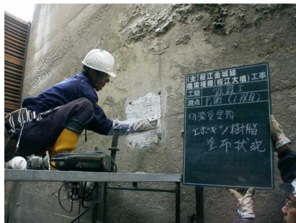
写真6 エポキシ系接着剤の塗布
