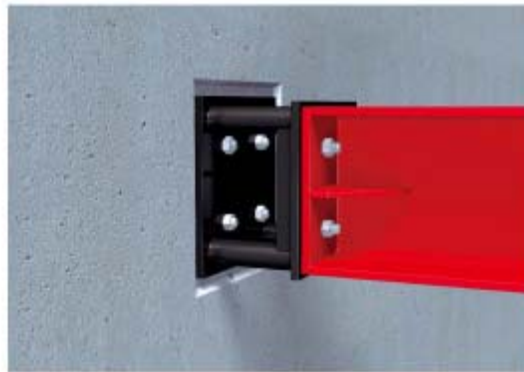
図7 スルーサーPの設置
