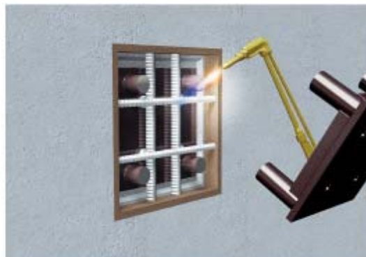
図 12 スルーサー P の切断
